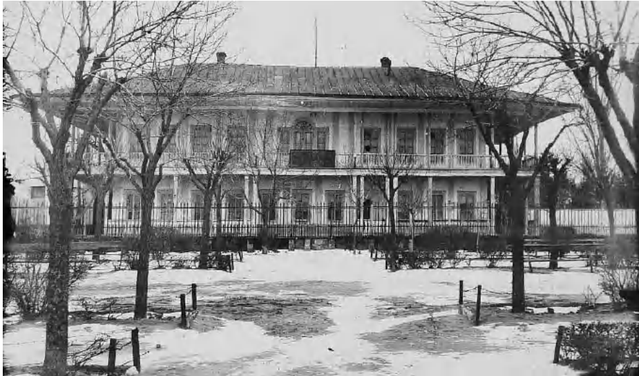
«Молдаванский дом». Сооружен в 1799 г. При вице – адмирале А.С. Грейге территория в районе Молдаванки превратилась в красивый Морской бульвар, здание было передано офицерскому сообществу в качестве помещения под Летнее морское собрание [Ю.Любаров].
