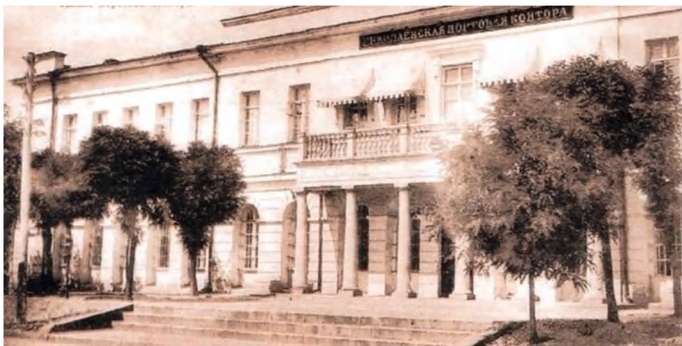
Здание конторы Николаевского порта
